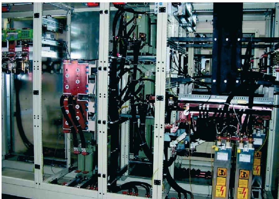
Рис. 35: Новая система преобразователя частоты БТИЗ в «Soer-Norge»
