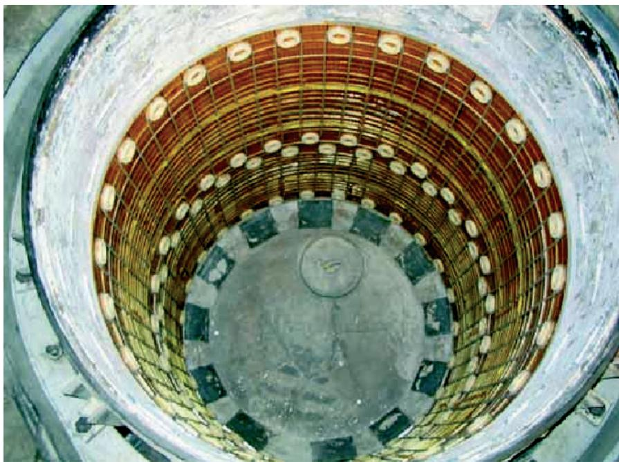
Рис. 24: Установка кабеля датчика ОСР
